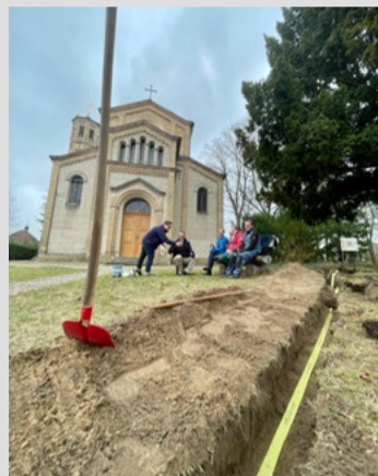
Arbeitseinsatz im Kirchpark
